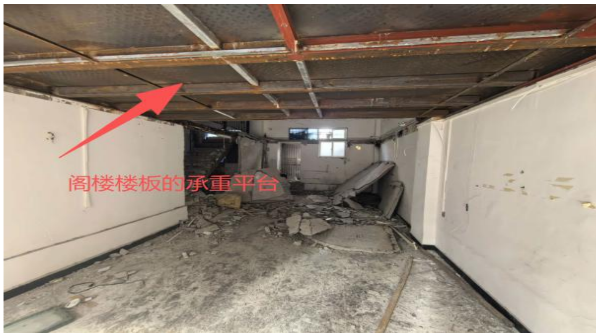
图 1 阁楼底部现场情况
