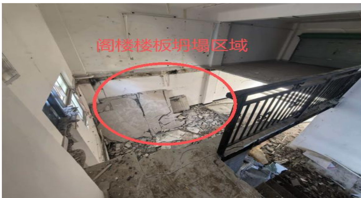
图 2 阁楼楼板拆除情况
