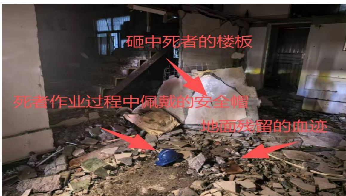
图 3 坍塌的阁楼楼板
