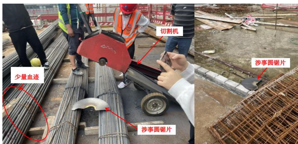
图 1 现场整体勘查情况
