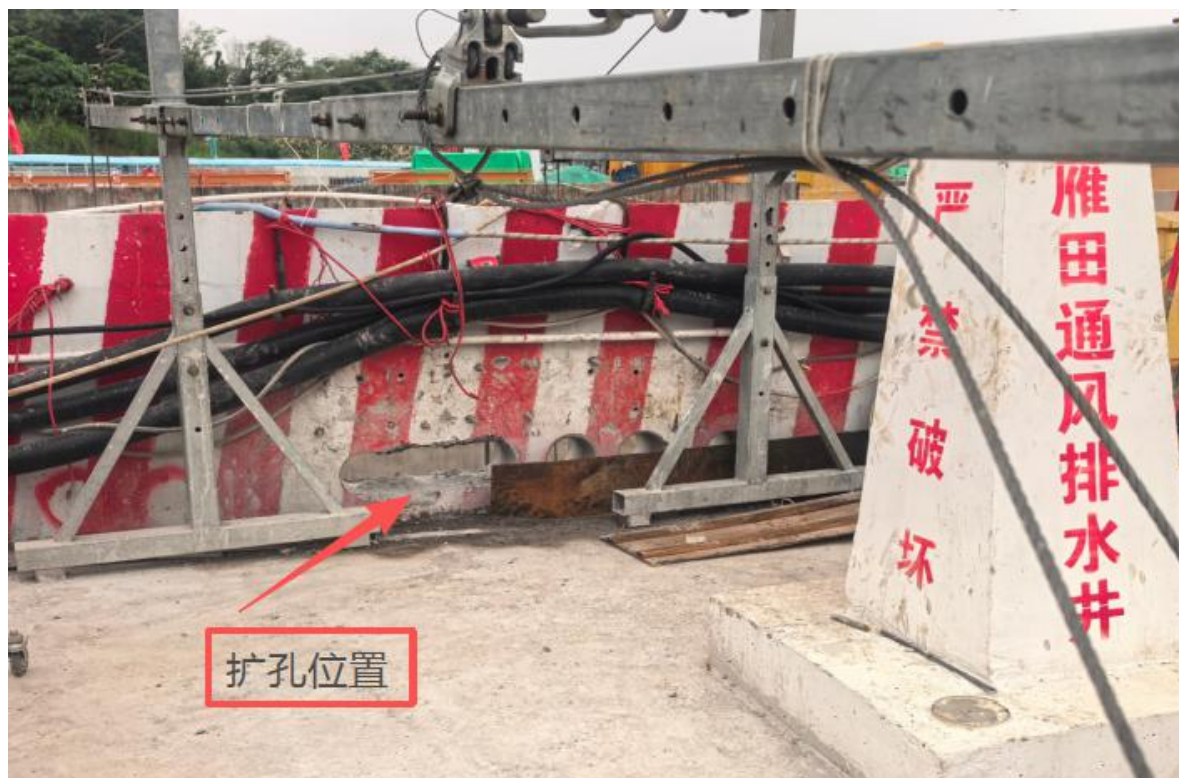
图 4 砂浆管安装孔
