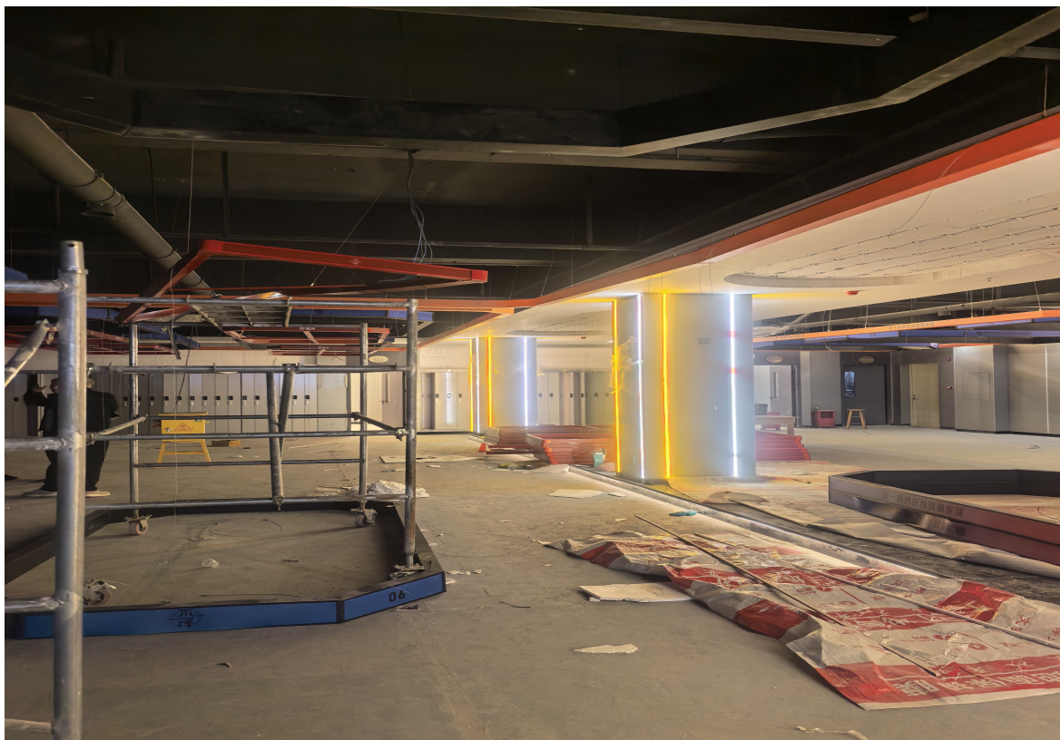
图 1 现场事故图片
