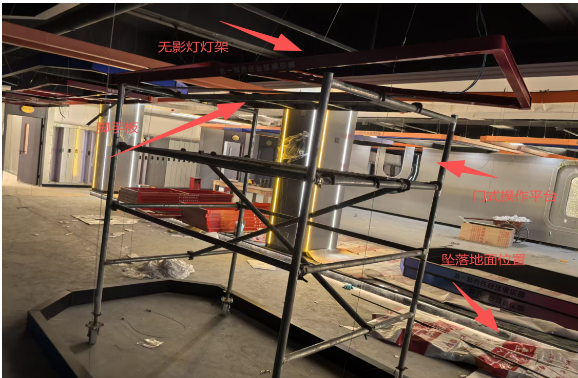
图3 涉事门式操作平台
