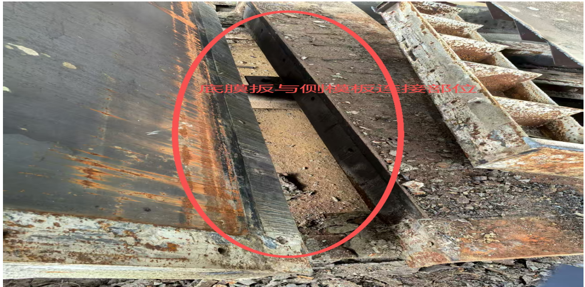
图 3 侧模与底模的紧固螺栓已拆除
