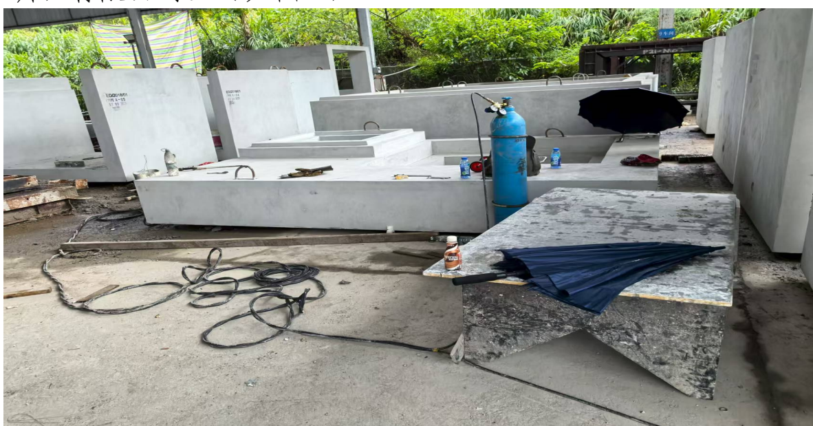
图4 拆解焊切模具的作业工具
