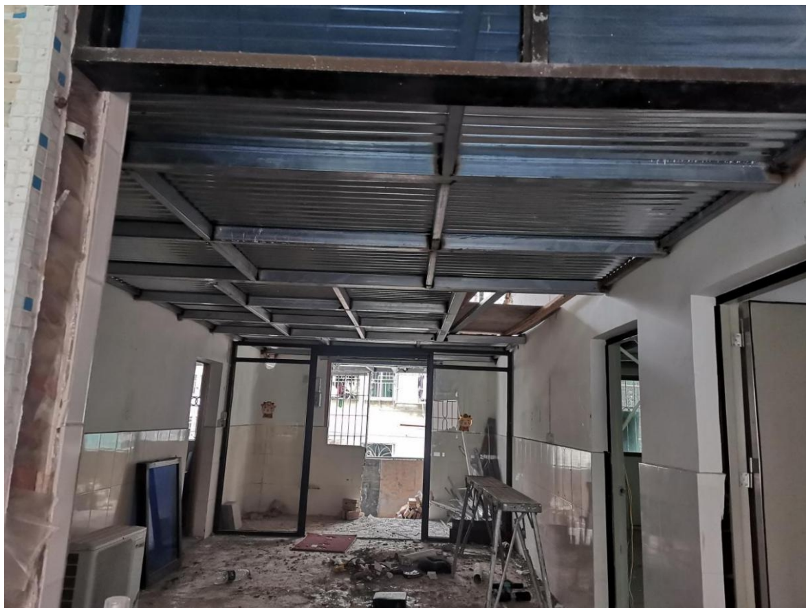
图 4 三楼内部改造情况
