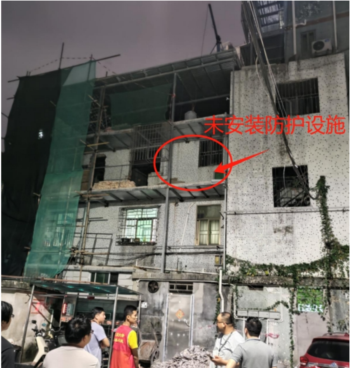
图5 三楼阳作业区临边处安全防护情况
