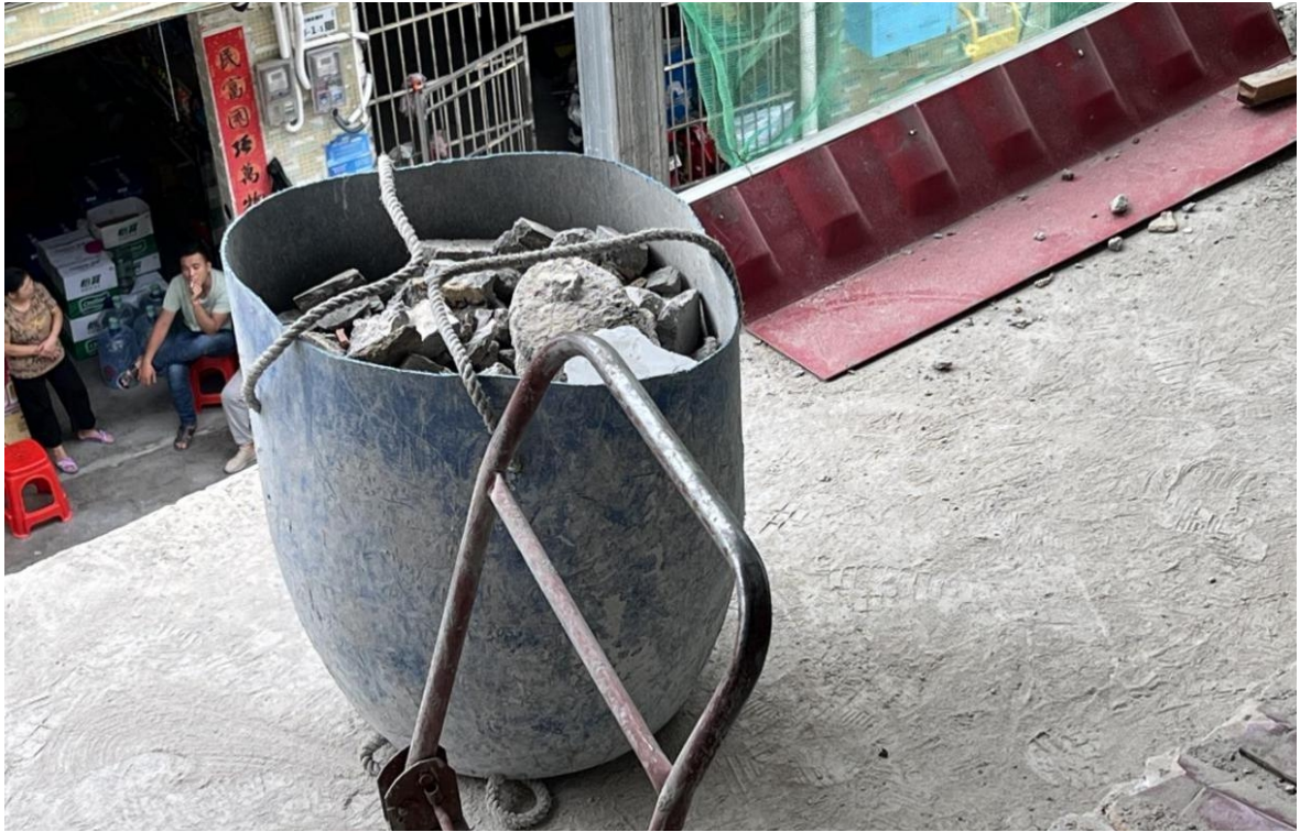
图 3 现场装满居民楼改造垃圾的吊桶
