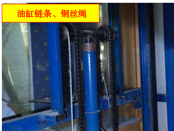
图 6 油缸两侧的链条和钢丝绳
