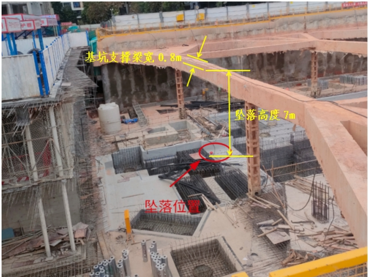
图2 基坑支撑梁至基坑底部高度
