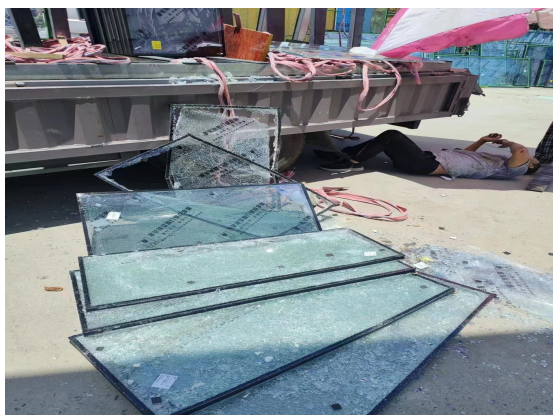
图 1：事故现场照片
