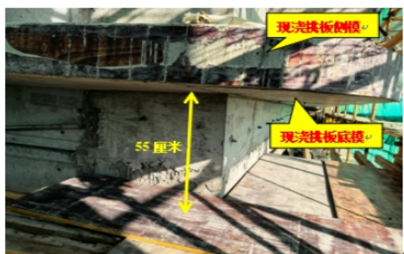
下飘板距 12 层悬挑脚手架硬质防护情况。
