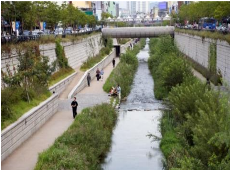
图 3.3-2 韩国清溪川暗渠复明工程
