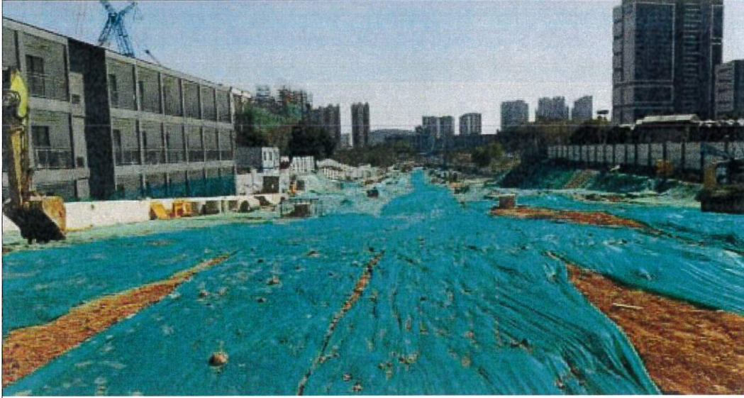
施工过程裸土覆盖
