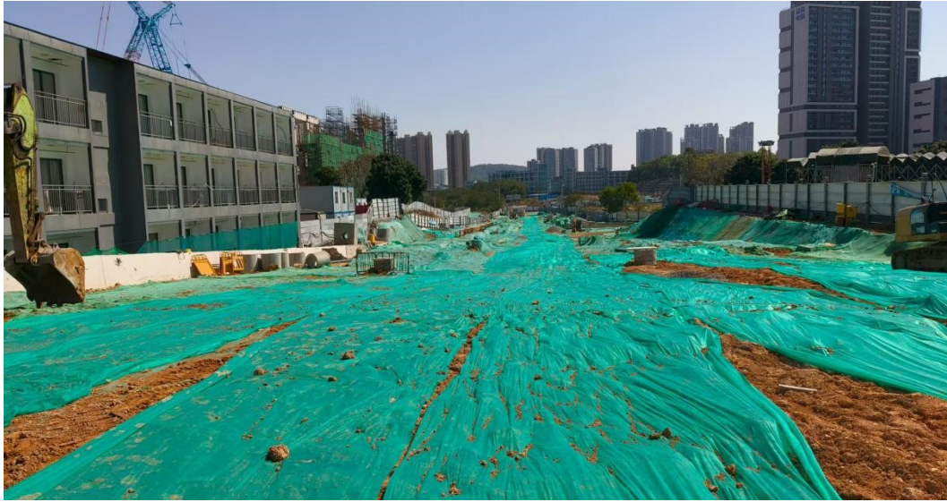
施工过程中裸土覆盖
