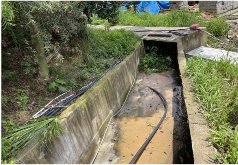
场地北侧 2.0×1.5m 排水沟
