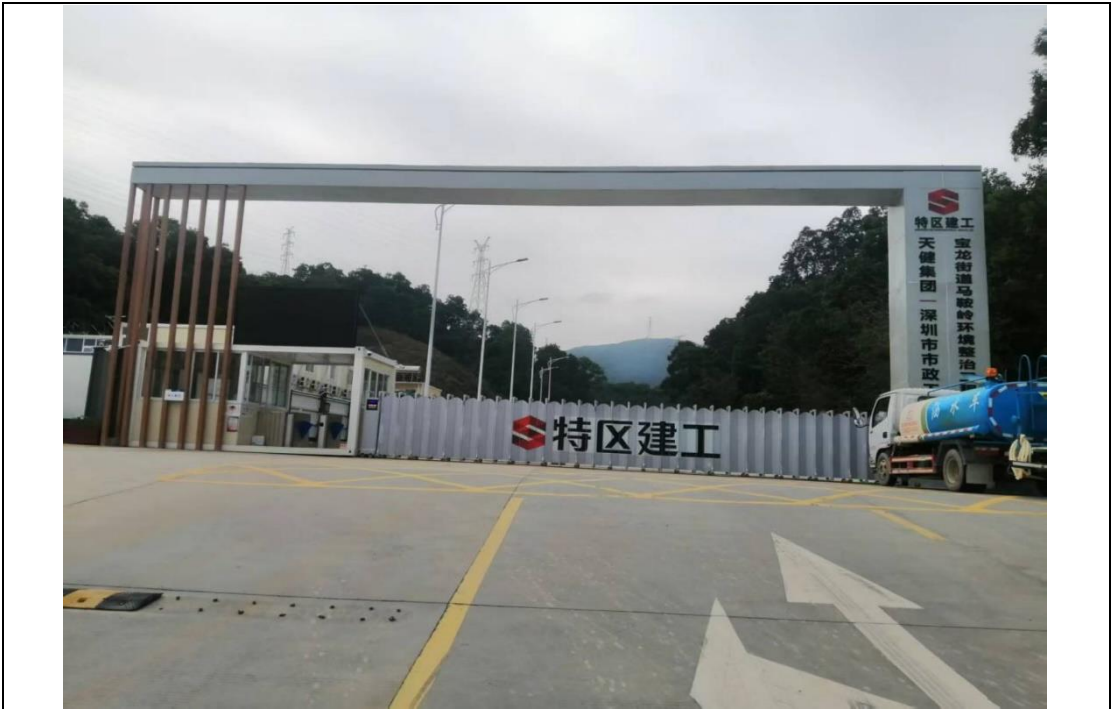
施工期现场大门照片
