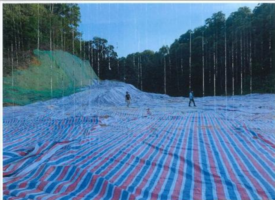
已加强裸露地表的覆盖防护措施并落实完善项目区排水沉沙体系
