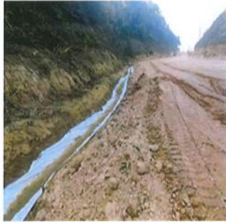
整改问题2：项目区已建截排水、沉沙等措施较水土保持方案设计工程量偏少，现有沉沙池布设不规范，排水管涵泥沙淤积，排水沉沙效果不佳，降雨期间易对下游排水系统及水二村支流等造成不利影响。
