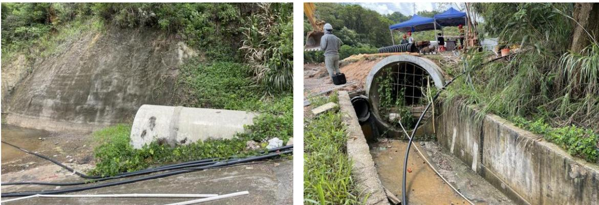
图 1-5 场地原状 DN1800 混凝土管
