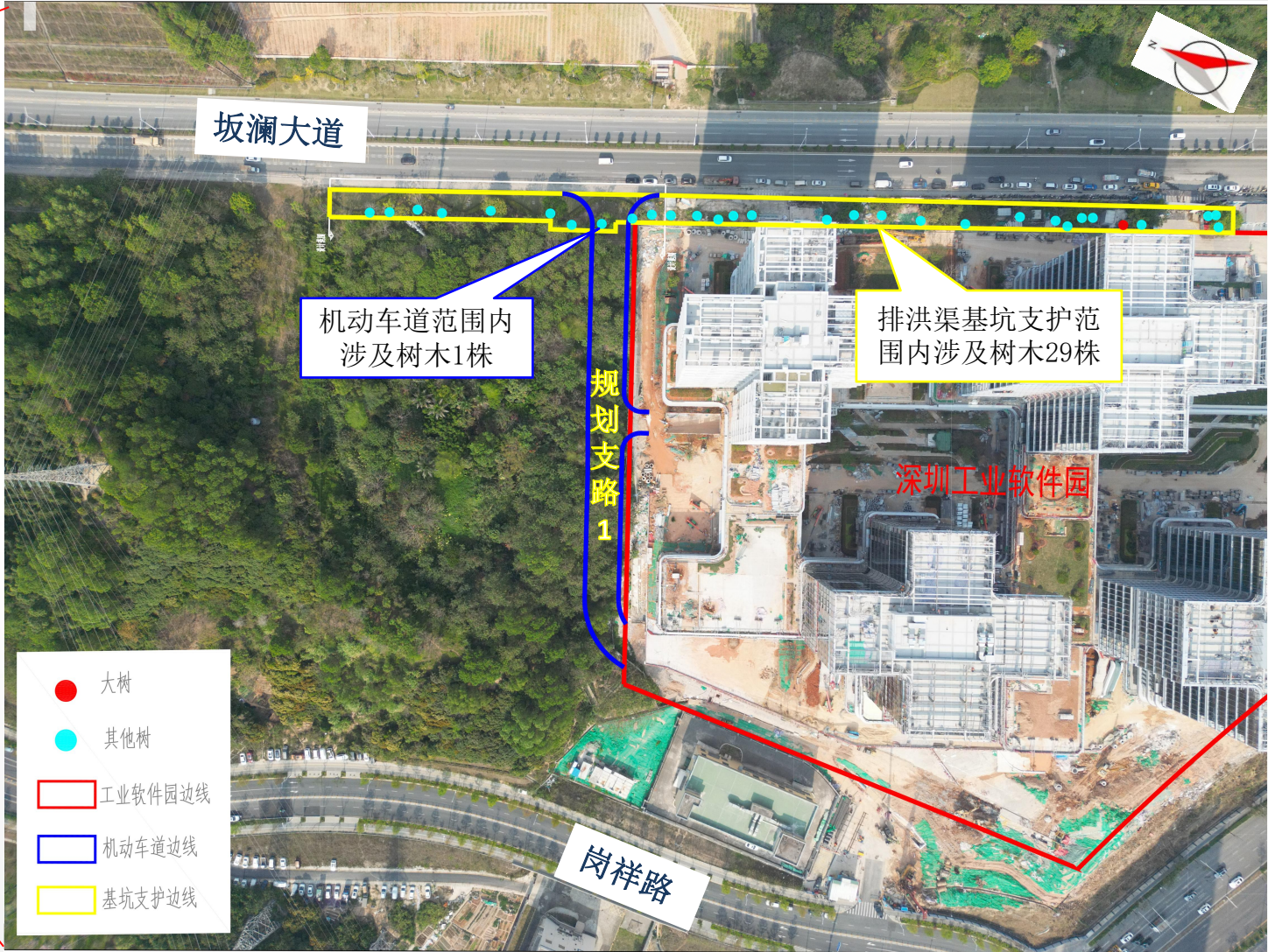
坂田街道坂澜大道和坂李大道交叉口西北角
