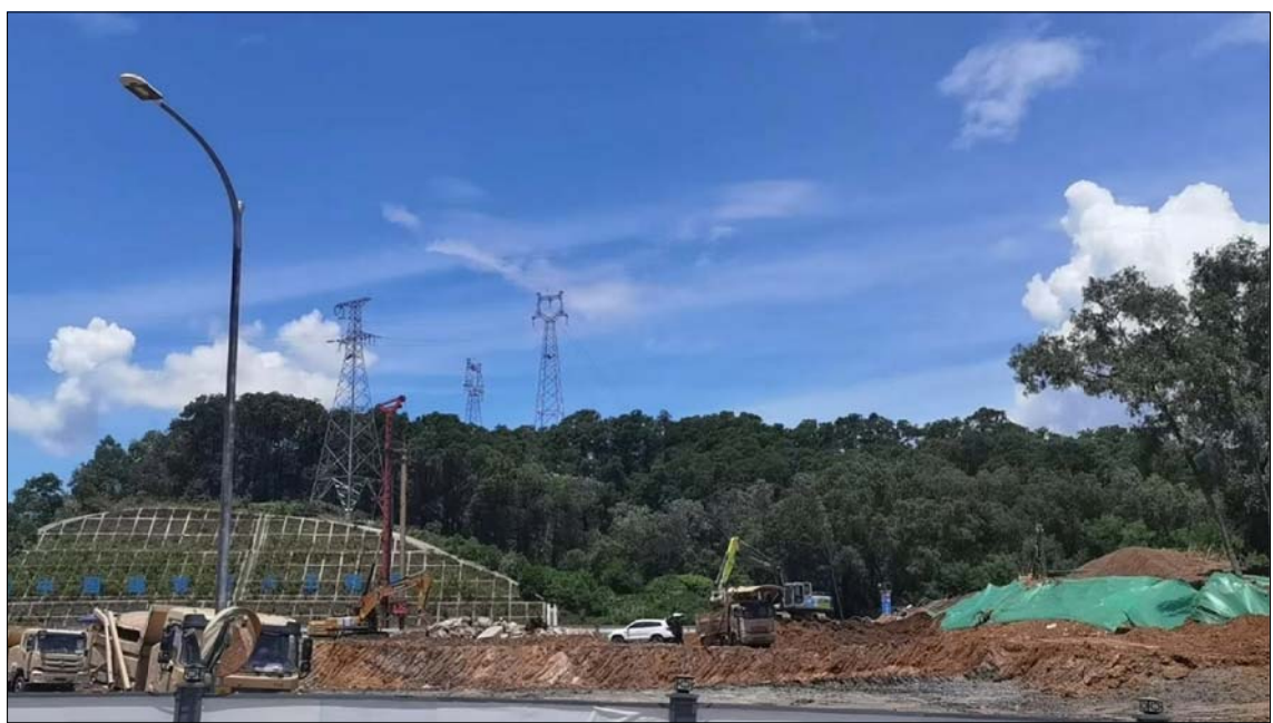
照片1: 八仙岭公园边坡地貌(镜头W)
