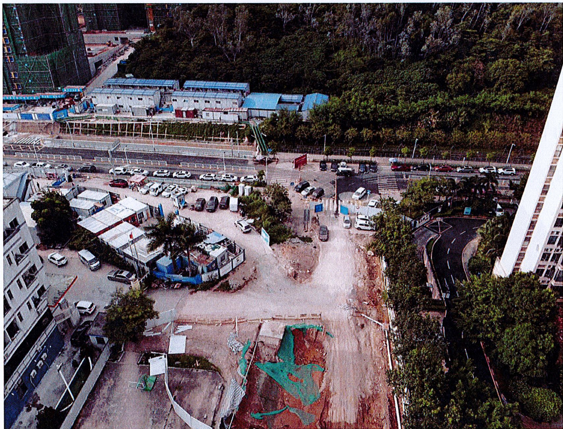
项目区北向及周边现状
