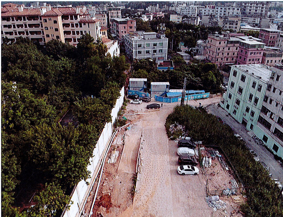
现状施工营地及洗车池
