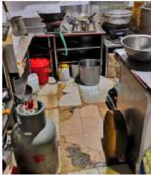
布吉街道布吉社区布吉一村 20 号（沙县小吃），（一）13、灶具无熄火装置
