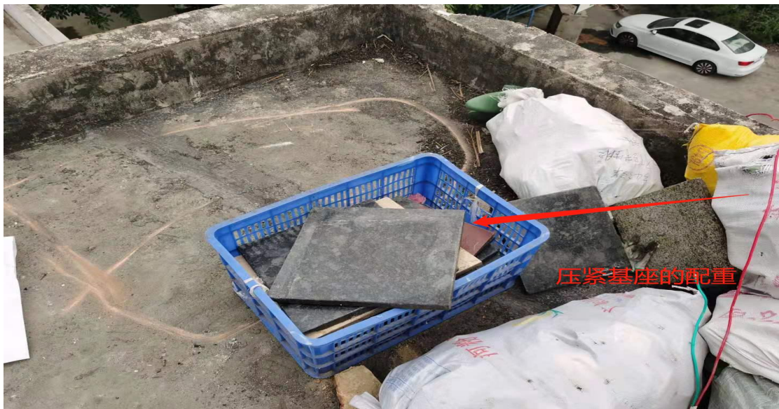
图 3 三楼平台临边提升机吊装作业区域
