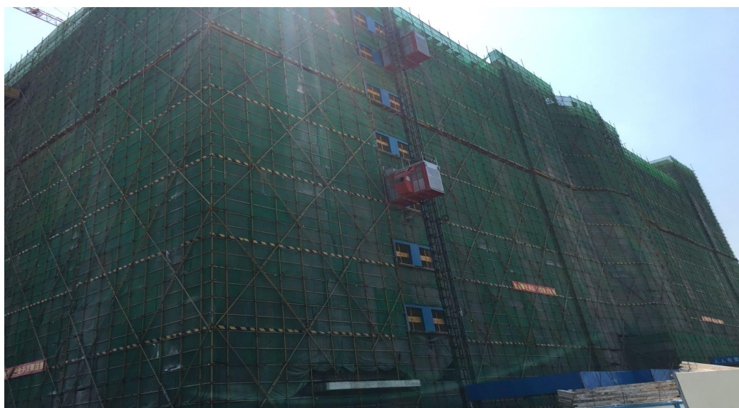
1 伯恩大楼在建工程
