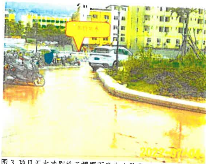
图 3. 项目汇水冲刷施工裸露面产生大量黄泥水顺势漫流进入黄竹坑水，对河道水环境造成危害。
